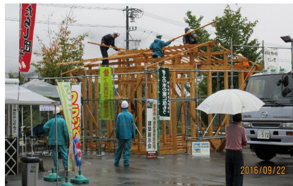
8月29日～9月4日 (木造応急仮設住宅建方実演中)
